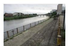
公園橋・水辺広場
