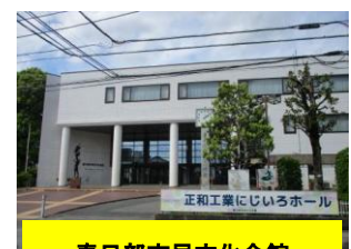
春日部市民文化会館 正和工業にじいろホール
