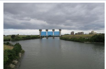
中之島からの新岩淵水門(青門)
