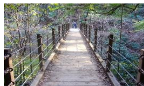
4号路・吊り橋
