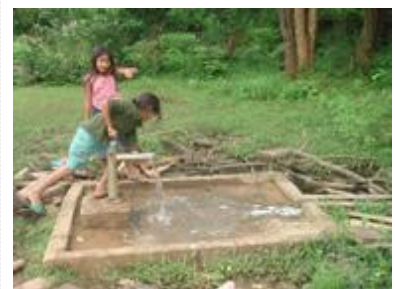
写真はチャンヌア小学校で掘り直した井戸【AEFAのHPより引用】
